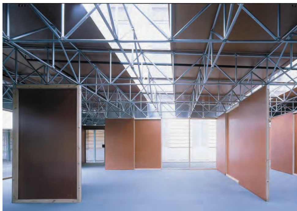
▶▶ und ▶▶▶ Temporärer Garderobenvorbau Der für die Ausstellung ›Jenseits der Großen Mauer – der Erste Kaiser von China und seine Terrakotta-Armee‹ von 1990 zu kleine Garderoben- und Kassenbereich musste durch einen temporären Vorbau ersetzt werden, Foto unten: Thomas Kupferstein, 1990
