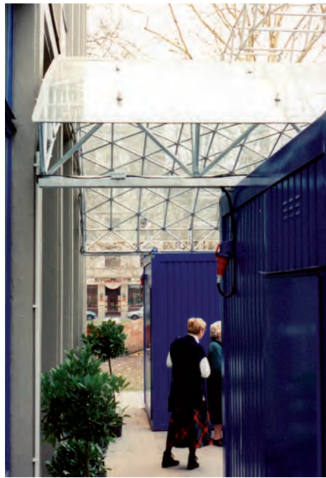
1996 Für das Museum am Ostwall in Dortmund markiert eine gewölbte, einschalige Vordach-Konstruktion den Eingang der Ausstellung ›Von der Brücke zum Blauen Reiter‹.
