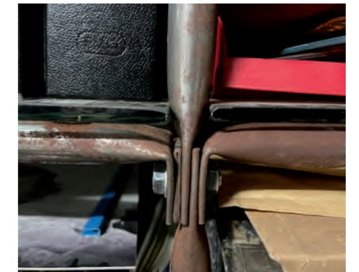
▼ Details der Regalversion von 1987 aus dem Martin-Gropius-Bau im heutigen Zustand. Das Ende jedes zweiten Verbindungsstabes ist hier um 90 Grad abgebogen.
