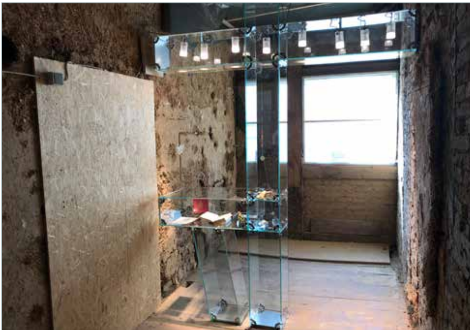
Alt und neu kombiniert: Die Vitrinen sind eine Sonderkonstruktion, die Kräfte werden auf den Boden oder zu der benachbarten Scheibe übergeleitet. Foto: Jürg Steiner
