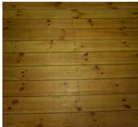
▶ Die Nadelholzdiele unter dem Fliesenbelag waren weitgehend nutzbar, obwohl der Kleber von allerbesten Güte war. Die Dielen sind abgeschliffen und mit Wachs eingepflegt worden, Aufnahme 8. Januar 2015.
