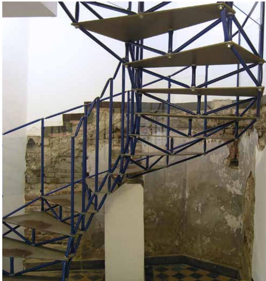
▲ Die geschwungene, Platz sparende Treppe als Abstieg zu den Herrentoiletten im Sockelgeschoss. Der Verlauf der Vorgängertreppe ist durch die noch vorhandenen Fliesenscheuerleisten gut zu erkennen. Eine vorgefundene Mauervorlage unterstützt die Stahlrohrkonstruktion.
