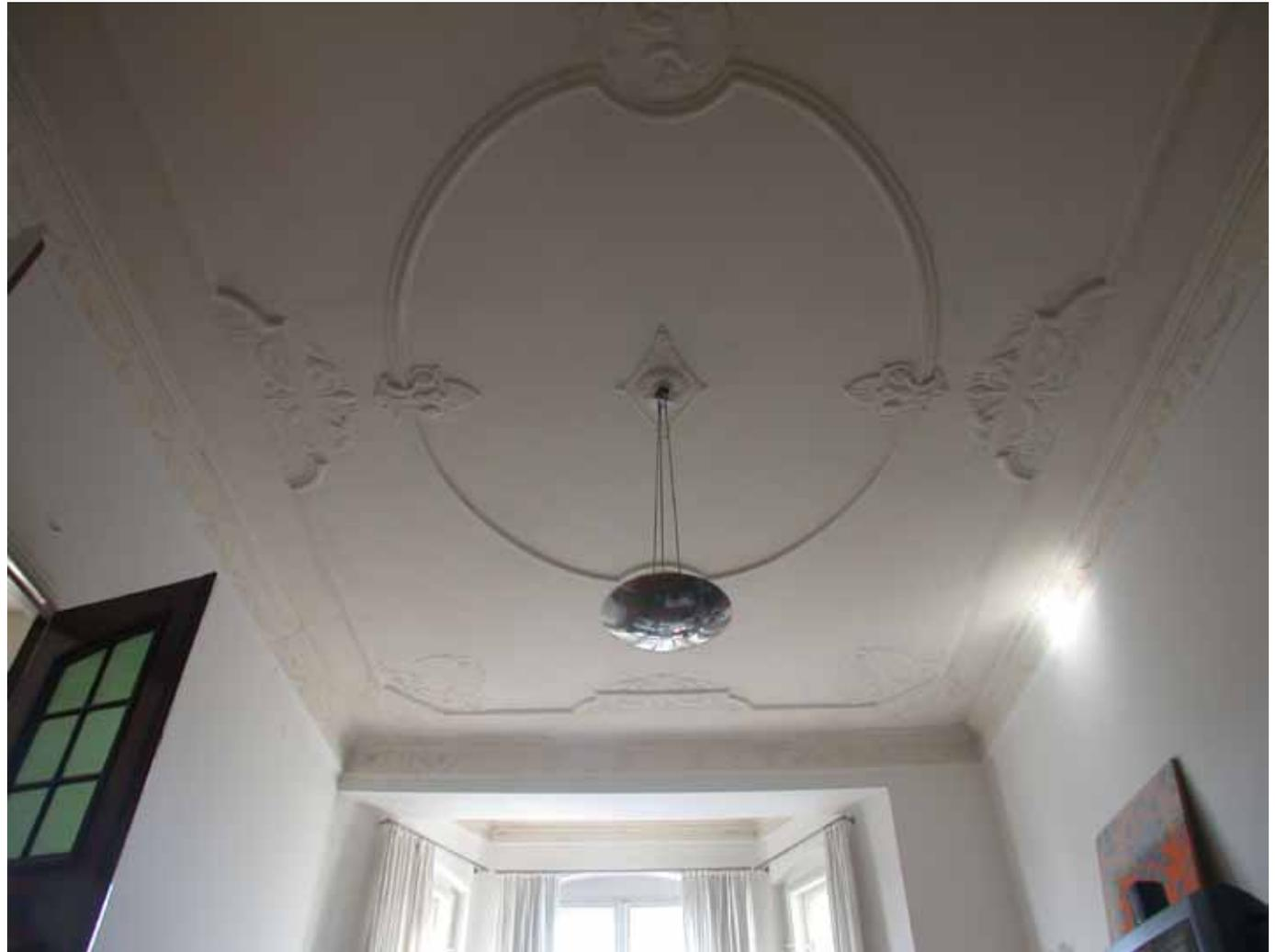
In den hinteren Zimmern bilden Voluten den Übergang von Wänden zur Decke. Neu und alt ergeben sichtbar eine Zäsur. Die unrenovierte Qualität des letzten Anstrichs der Decke im hintersten Zimmer ist mangelhaft, einzelne Farbfetzen lösen sich ab.
