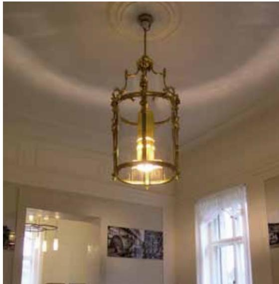
Im Leuchter des östlichen großen Saals im 1. Obergeschoss wirft eine Metaldampflampe ein Lichtband auf den Bilderfries in der oberen Raumhälfte und konzentriertes Licht auf eine darunter stehende Tischvitrine.
