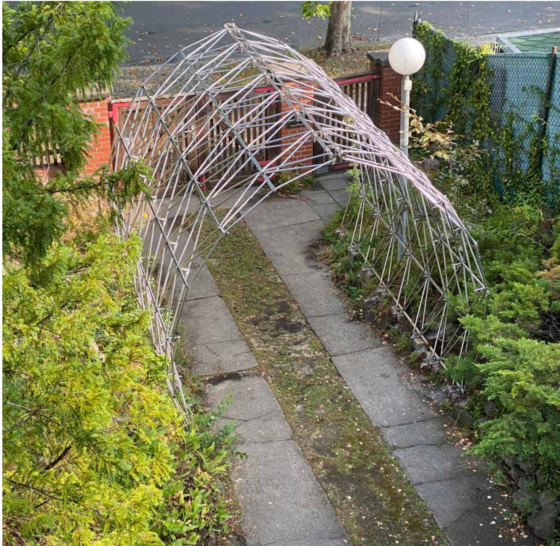
filen über die ganze Breite des Systems eingebaut worden. Diese Profile wurden auch im Hinblick auf zukünftige Bauwerke erprobt, um so die Eignung für Befestigung flacher Platten als Eindeckung, wie beispielsweise Fotovoltaik-Elemente, auszuprobieren. Bei der hier vorgestellten Pergola ist an eine Eindeckung nicht gedacht, die Netzstruktur setzt auf natürlichen Bewuchs.
