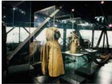
Die Glasscheiben (8 mm starkes Einseibensicherheitsglas) wurden in Deckelrahmen aus verschweißtem Flachstahl und verschraubtem Basissockel
