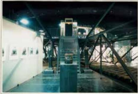
Die Ausstellung selbst findet hauptsächlich auf der Oberseite der Scheibe statt, in 24 Segmenten aus denen die Scheibe montiert ist, begrenzt durch strahlenförmige Gitterträger. Diese Gitterträger sind auch die bestimmenden Raumformations-elemente, die der Binnenarchitektur ihre Ordnung geben.
