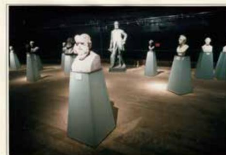
Genug des Glases? Nein. Selbst ein Teil der Sockel wurden aus diesem Material gefertigt oder um ehrlich zu sein, mit Glas verblendet. Eine Stahlrohrkonstruktion, mit einem oberen Abschluss in Form einer Flachstahlplatte, wird von vier trapezförmigen, mattierten Verbundsicherheitsplatten zu einem Pyramidenstumpf verwandelt. Kann man sagen, dass der Sockel durch das Glas leichter wird, weil er einerseits etwas von dem Hintergrund durchschimmern lässt und eine unverzerrte Reflektion erzeugt?
