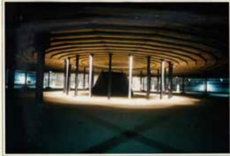
Eine Scheibe schwamm während des Betriebs als Gasbehälter auf dem Gas, ein ähnliches Prinzip wie das einer Fahrradpumpe. Diese Scheibe ist nunmehr auf einer Höhe von vier Metern verankert, zusätzliche Stützen ermöglichen die Nutzung des Oberscheibenraums, über dem sich der fast 100 m hohe Raum erhebt.
