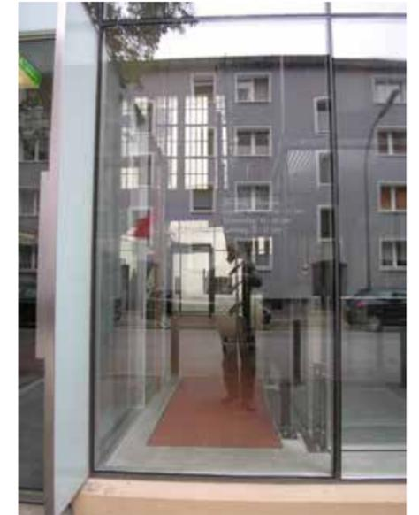
▶ ▲ Stahl-, Holz-, Glasfassade mit Türen aus dem speziell für die Adaption von vorhandener, wenig veränderter Bausubstanz entwickelten »Rahmen 2000«, Maßstab 1:10, 3. Januar 2006
