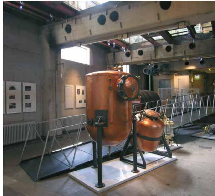
Rohr 28/1,5 mm liegt in der Ausformung der beiden Geländer, die zugleich als tragende Fachwerkträger fungieren. Dank der biegesteifen Einspannung der Diagonalen am Fußpunkt wird der Druckgurt, der zugleich Handlauf ist, am seitlichen Ausknicken gehindert und kann seine volle Tragfähigkeit zur Aufnahme von Normkräften zur Anwendung bringen.
