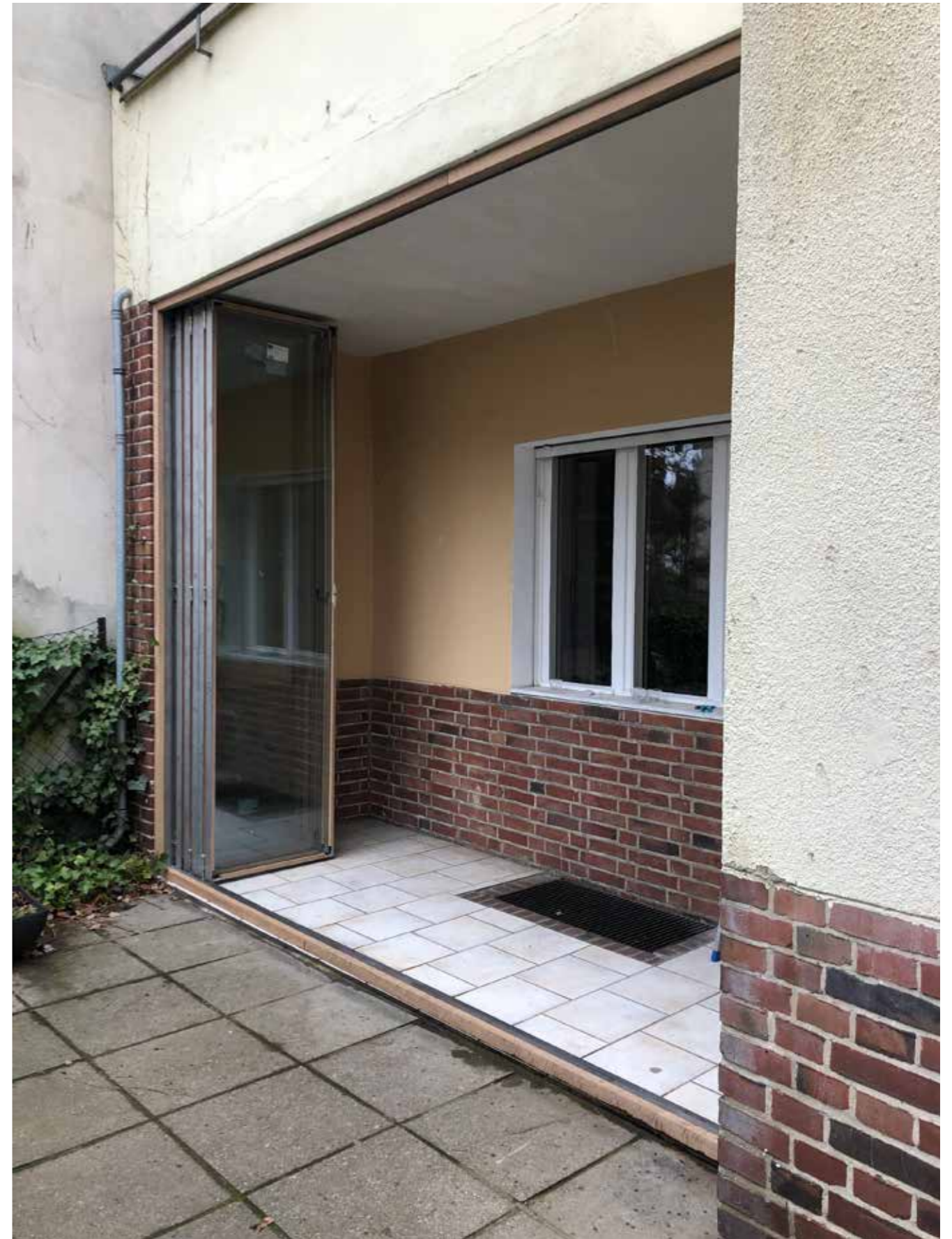
▲ Offener Wintergarten in fast fertigem Zustand, 15. März 2019
